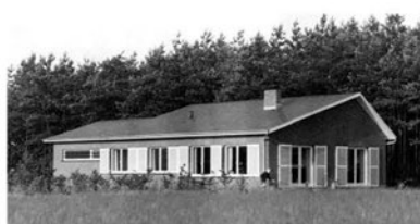
Heibaan / Heidedreef 26, Pulle
